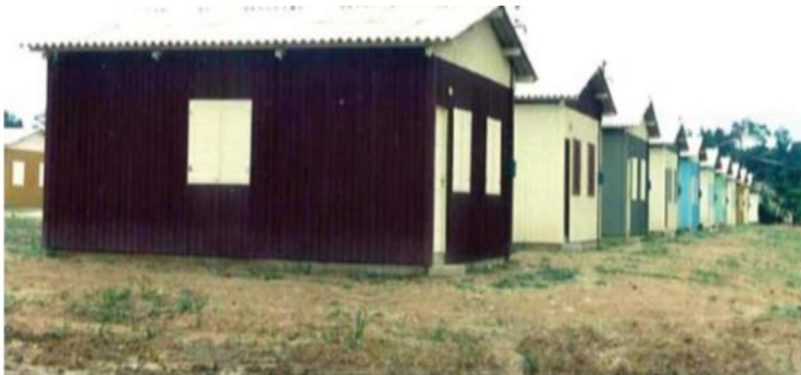
Figura 9: Primeiras reformas nas casas de pessoas reassentadas no Novo Breu
